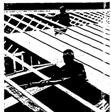
Das Perennator - Kittverfahren. Bild 1. Das Arbeiten mit der Handspritze. Sie arbeitet vollkommen selbsttätig durch Anwendung von Preßluft. (Sonderaufnahme f. d. „Gartenwelt“.)
