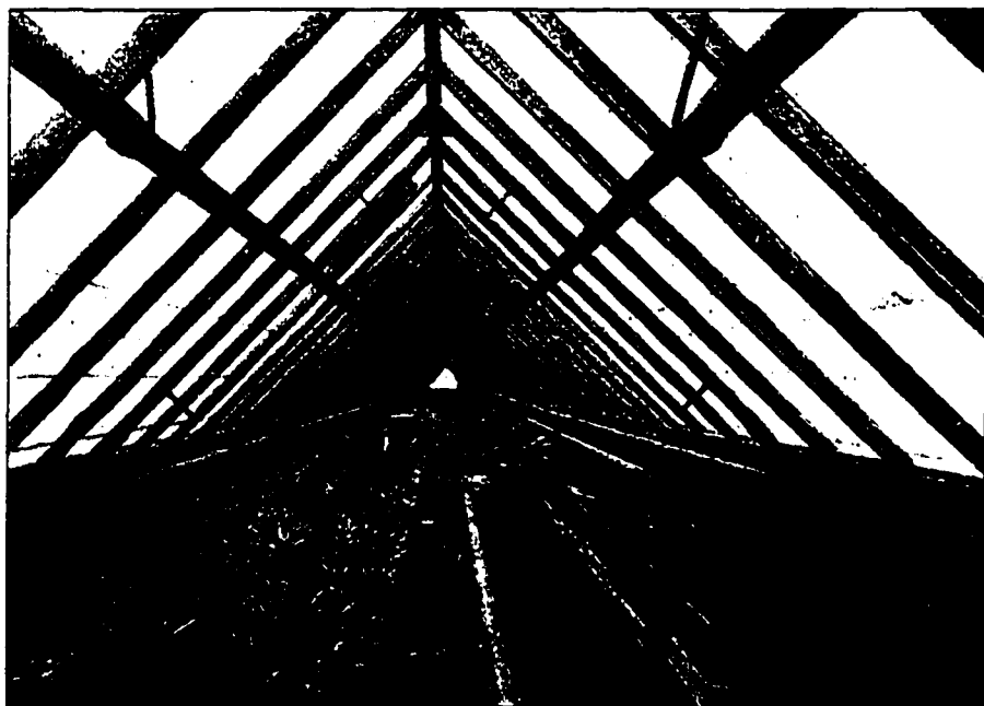
Gewächshausbauten in Beton.
