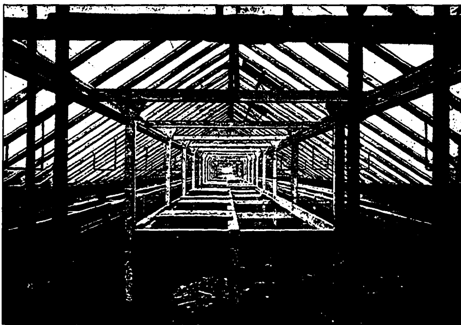
Gewächshausbauten in Beton.
