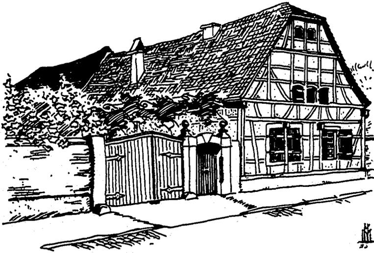
Als der große Eichenholzvorrat nach dem Raubbau des Mittelalters zur Neige ging, da erhielt nur noch das obere Geschoß das Fachwerk. Aber auch so zeigt sich der unvergängliche Reiz einer bodenwüchsigen, Jahrhunderte überdauernden Bauart, bei der Konstruktion und Schmuck, Funktionelles und Aesthetisches einen harmonischen Bund schließen.
