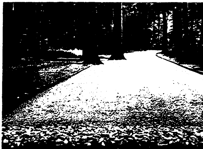
Für die Inntränkung mit Kaltasphalt vorbereitete Befestigung
