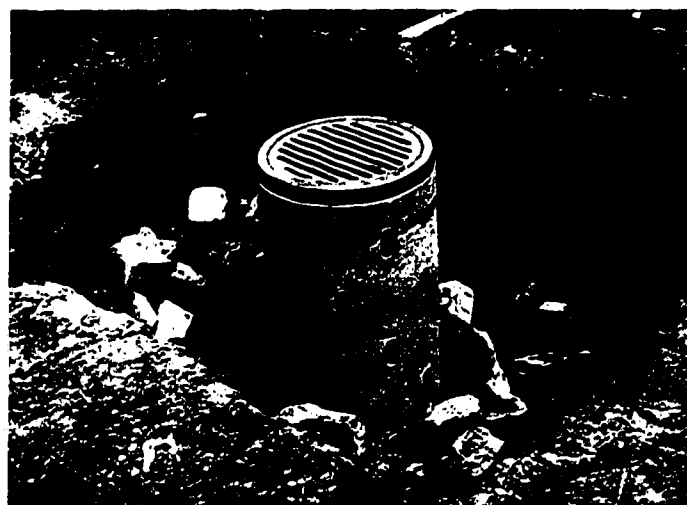
Einbau eines Sickerschachtes
