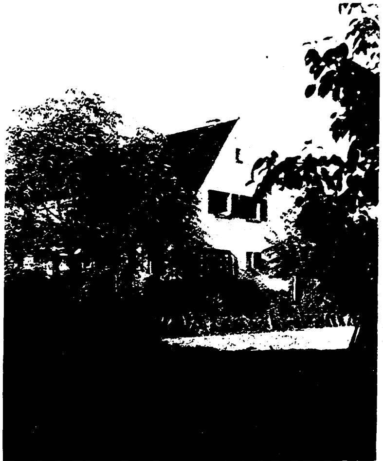
Frankfurt a. M., Siedlung Riederwald, Einfamilienhaus; Aktienbaugesellschaft für kleine Wohnungen; Gartenarchitekt H. Beckstein, Frankfurt a. M.
