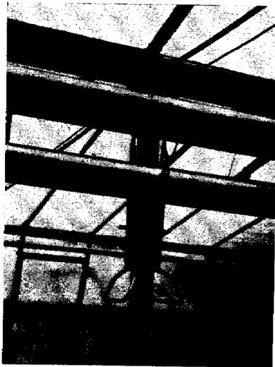
Aufbauen des Blocks werden zunächst die Eisenträger aufgestellt, die Einzelstücke der Laufstege aneinander gereiht und auf diese dann die 2,50 m breiten Einzelstücke der Glasflächen aufgelegt. Die hohlen, runden Träger, die in 40 cm tief eingelassenen Betonsockeln ruhen, sind nicht mit dem Sockel vermauert, sondern ruhen lediglich in genau abgepaßten Öffnungen der Sockel. Träger und Sockel können also getrennt transportiert werden, was das Arbeiten wesentlich erleichtert.
